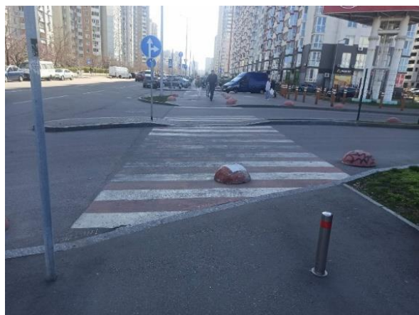
Рисунок 5 — Стан дорожньої розмітки
